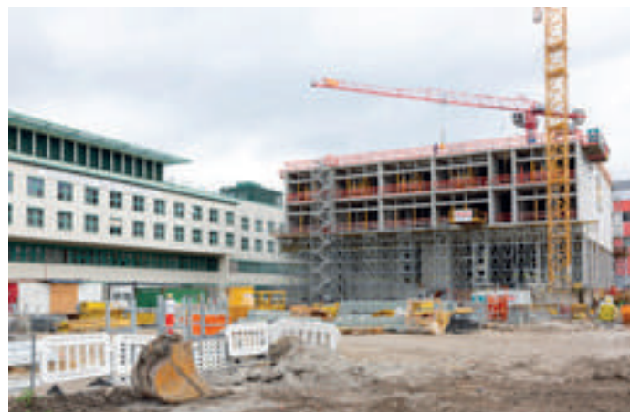
Der Rohbau des neuen Lehrgebäudes nimmt Form an.
