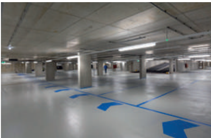
Blick in die noch leere Tiefgarage am Med Campus mit 367 Stellplätzen
